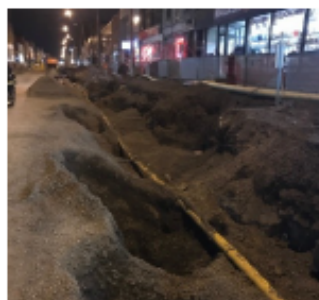
Très grande tranchée (rue ouverte, évacuation facile)
