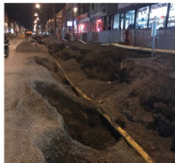
Très grande tranchée (rue ouverte, évacuation facile)
