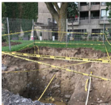
Tranchée (évacuation difficile)
