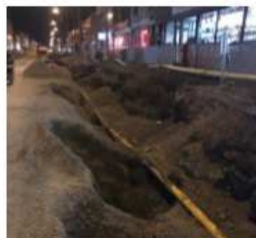
Très grande tranchée (rue ouverte, évacuation facile)
