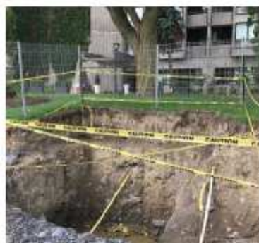
Tranchée (évacuation difficile)
