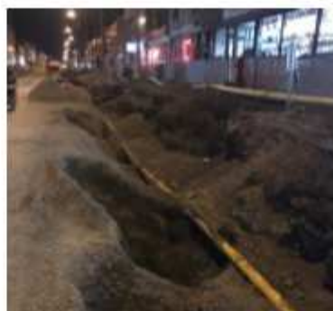
Très grande tranchée (rue ouverte, évacuation facile)
